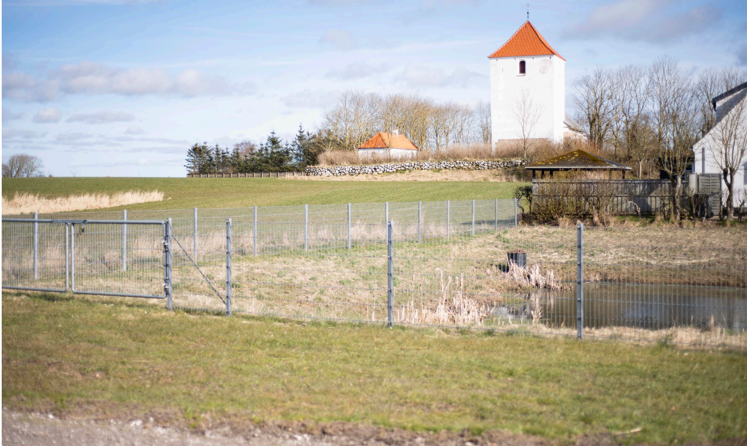
14. Vester Assels Kirke - Eksisterende forhold
