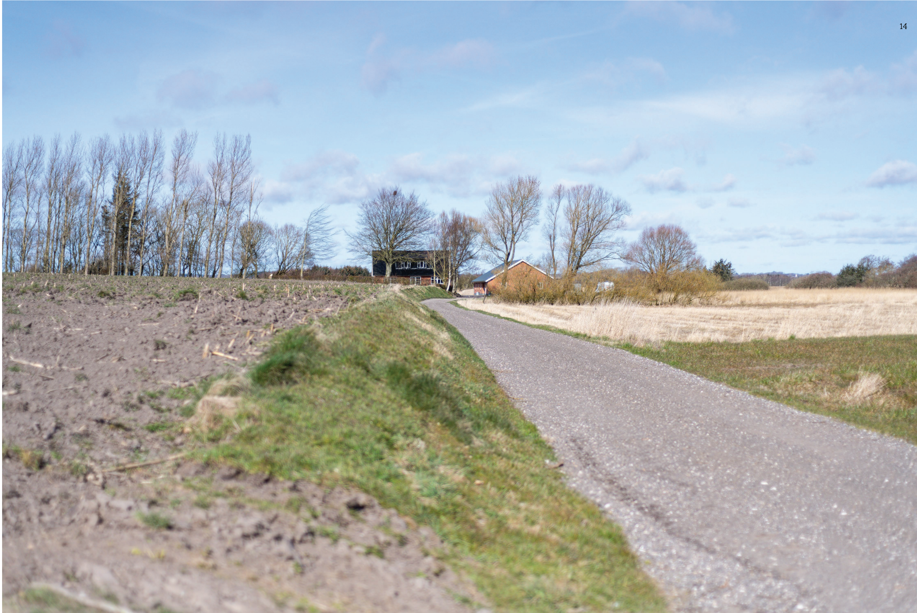
05. Vester Assels – Eksisterende forhold
